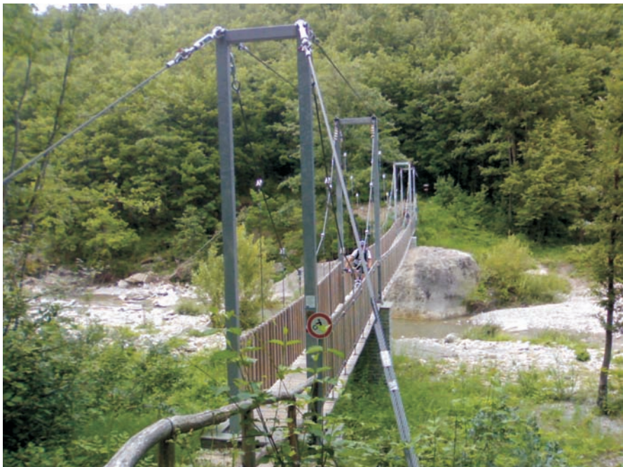
PASSERELLA PEDONALE SOSPESA SUL TORRENTE BAGANZA
